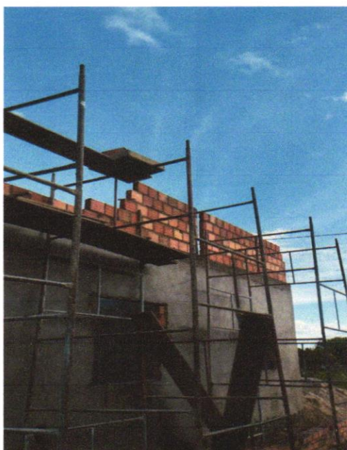
FOTO 04 – ALVENARIA DE VEDAÇÃO DE BLOCOS CERÂMICOS FURADOS NA VERTICAL DE 9X19X39CM (ESPESSURA 9CM) DE PAREDES COM ÁREA LÍQUIDA MAIOR OU IGUAL A 6M 2 COM VÃOS E ARGAMASSA DE ASSENTAMENTO COM PREPARO EM BETONEIRA. AF_06/2014
