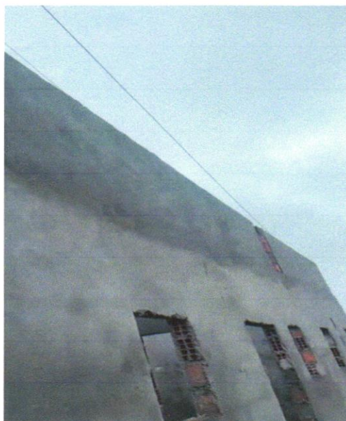
FOTO 10 – MASSA ÚNICA, PARA RECEBIMENTO DE PINTURA, EM ARGAMASSA TRAÇO 1:2:8, PREPARO MANUAL, APLICADA MANUALMENTE EM FACES INTERNAS DE PAREDES, ESPESSURA DE 10MM, COM EXECUÇÃO DE TALISCAS. AF_06/2014
