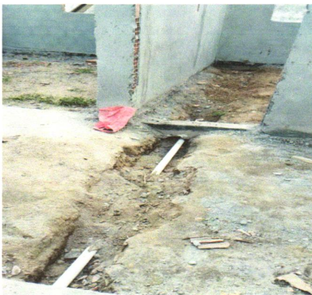
FOTO 05- (COMPOSIÇÃO REPRESENTATIVA) DO SERVIÇO DE INSTALAÇÃO DE TUBOS DE PVC, SÉRIE R, ÁGUA PLUVIAL, DN 75 MM (INSTALADO EM RAMAL DE ENCAMINHAMENTO, OU CONDUTORES VERTICAIS), INCLUSIVE CONEXÕES, CORTE E FIXAÇÕES, PARA PRÉDIOS. AF_10/2015
