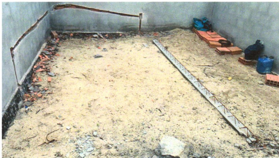
FOTO 11 – ATERRO MANUAL DE VALAS COM AREIA PARA ATERRO E COMPACTAÇÃO MECANIZADA. AF_05/2016
